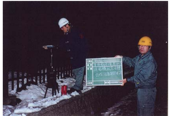
敷地境界における騒音測定
